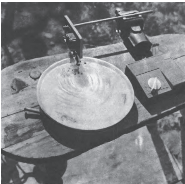
Рис. 1. Установка для наблюдения волн от одиночного источника
